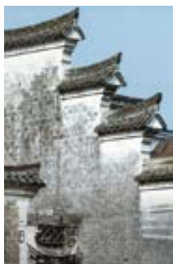
Рис. 2. Противопожарная стена жилых домов района Хуэйчжоу. Выбрано из «Карты древней архитектуры Аньхоя», 2015 г., автор Ван Нань
