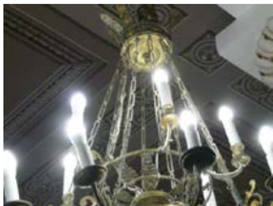
Рис. 4–5. Детали люстры: цепи с прямоугольными звеньями; крепеж (стакан, закрывающий подвесной крюк) к потолку, характерная форма деталей «ствола»
