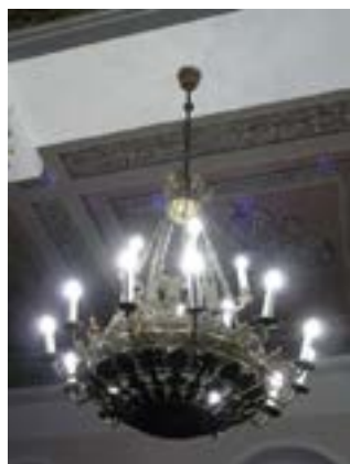
Рис. 2–3. Расположение люстр в колоннаде: три люстры между колоннами крепятся к архитраву; двухъярусная люстра на цепях
