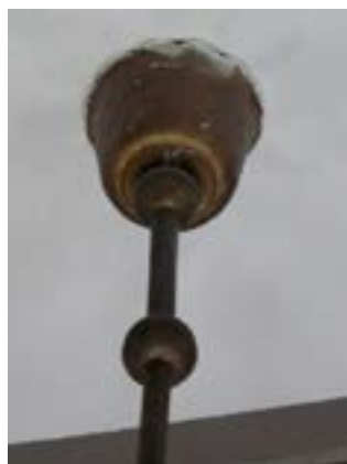
Рис. 4–5. Детали люстры: цепи с прямоугольными звеньями; крепеж (стакан, закрывающий подвесной крюк) к потолку, характерная форма деталей «ствола»
